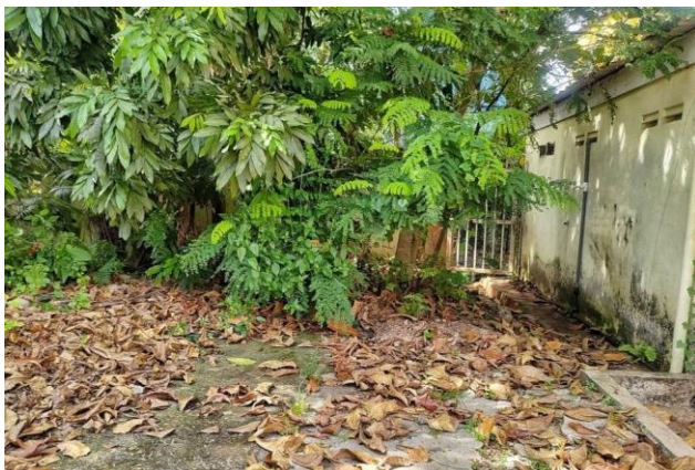
Keadaan persekitaran yang tidak terurus dan pintu belakang tidak berkunci.
