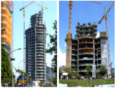
Kerja Pembinaan Menara KPWKM di Putrajaya
